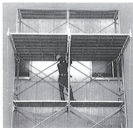
梁材と斜材の取付金具のカプラーを本締め
