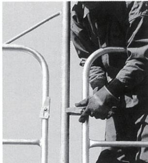
▲建柱に上部金具を突きあてます。
