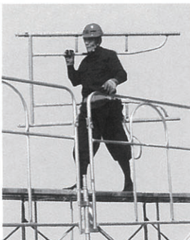
▲建柱を肩に担つぎ、片手はスカイガード手すりにつかまりながら移動中。
