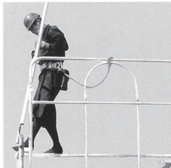
▲足場の先端部に建柱を取り付ける場合にはスカイガードの手すりに安全帯を取り付けます。
